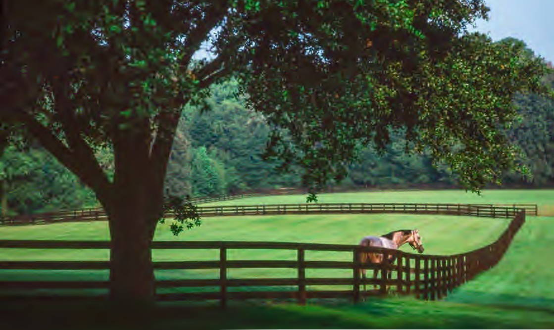
Ein Stabilzaun aus Holz mit vier Querriegeln.
